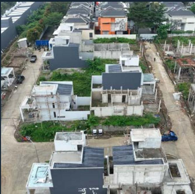
Pembangunan hunian di Centronia Residence terus bergerak maju dengan signifikan. Saat ini, 10 rumah telah memasuki tahap *finishing* yang meliputi pelapisan dinding dan lantai, penyelesaian fasad, serta pengecatan akhir untuk
